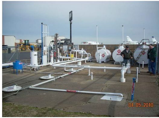
Ejemplo de configuración de tuberías
