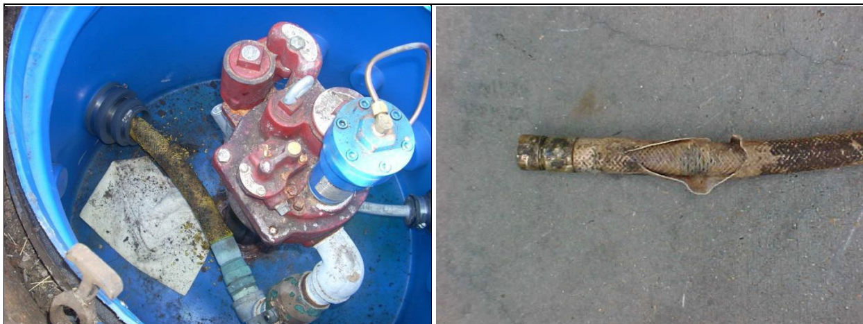
La 1. ra generación de tuberías TCI se retiró en 1995 y se sustituirá de acuerdo con la política de la División 4
