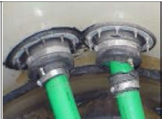
2. Arranque de prueba Environ Geo-Flex fijada al racor de penetración; arranque de prueba a la derecha
