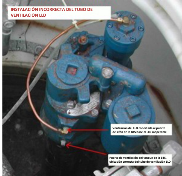
Instalación incorrecta del tubo de ventilación del MLLD (puerto de sifón superior), el MLLD no funciona.
