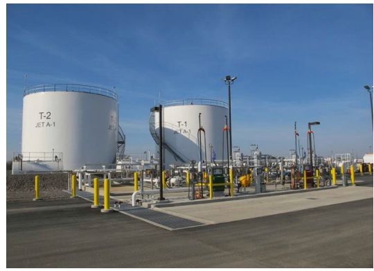
Ejemplo de parque de combustible con UST y AST
