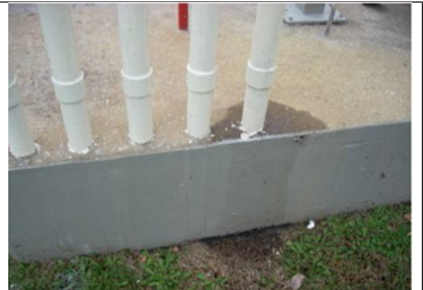
एक ओवरफिल्ड टैंक वेंट पाइप से रिलीज का कारण बन सकता है
