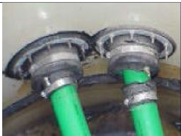
2. एनवायरन जियो-फ्लेक्स परीक्षण बूट प्रवेश फिटिंग से जुड़ा हुआ है; परीक्षण बूट दाईं ओर
