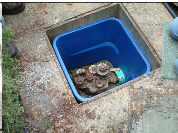
बैकफ़िल को पंप हेड में धंसने से बचाने के लिए एक प्लास्टिक कंटेनर का उपयोग करके अनियंत्रित नाबदान। यह वर्तमान स्थापना मानकों को पूरा नहीं करेगा।
