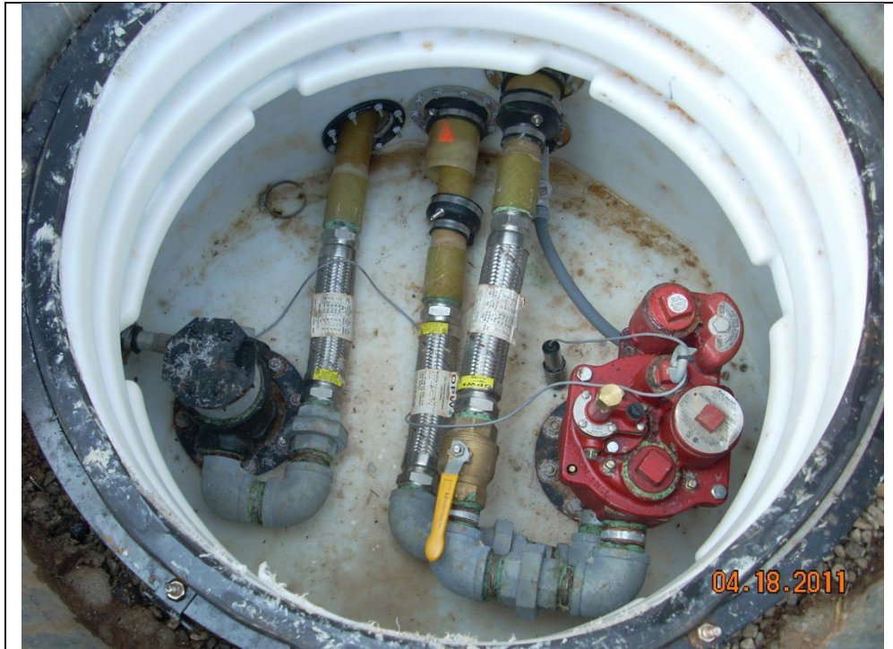
एक अंतरालीय सेंसर से लैस दबावयुक्त आपातकालीन जनरेटर प्रणाली।
